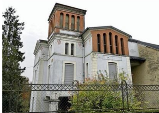
Villa Koppes von der Seite: Im oberen Loggiaturm könnte eine Dachterrasse eingerichtet werden, der Anbau rechts soll abgerissen werden
